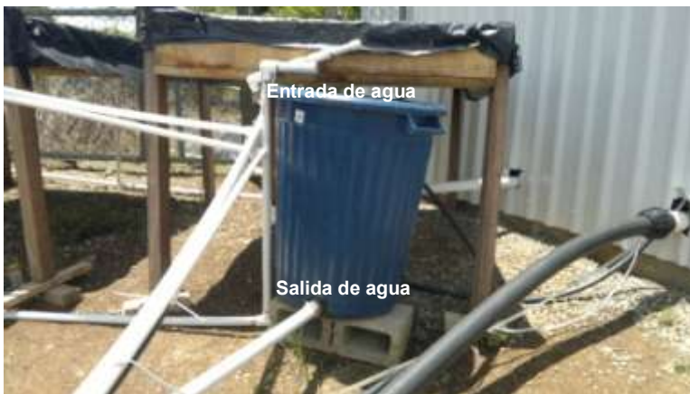
Figura 4.22. Entrada y salida de agua del biofiltro.
