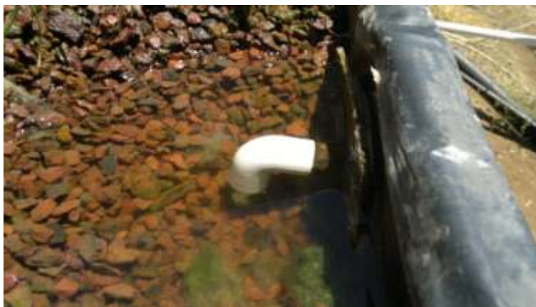
Figura 4.13. Vista de la salida de agua al momento del llenado de la cama.
