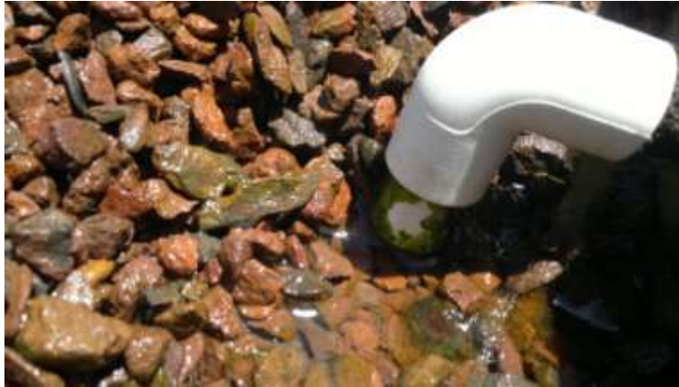
Figura 4.14. Vista de la salida de agua al vaciarse la cama.
