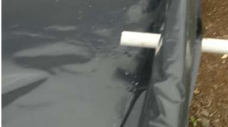
Figura 4.12. Construcción de la salida de agua.
