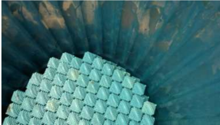
Figura 2.2. Disposición en capas de las bio-bolas.
