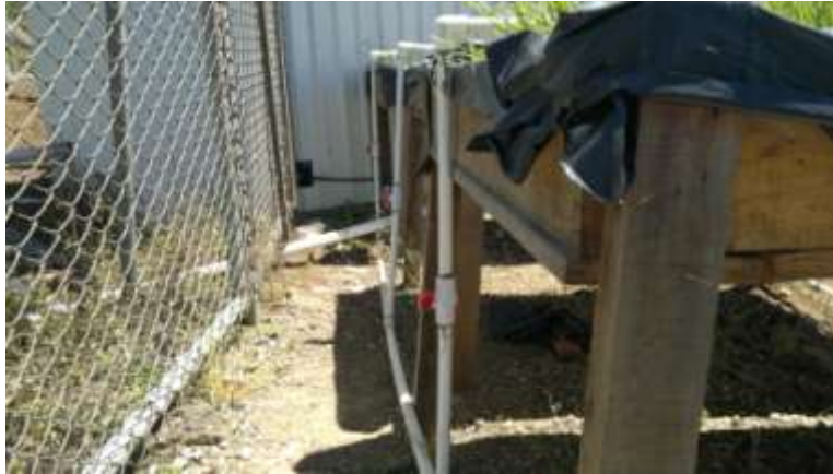
Figura 4.10. Disposición de las entradas de agua.
